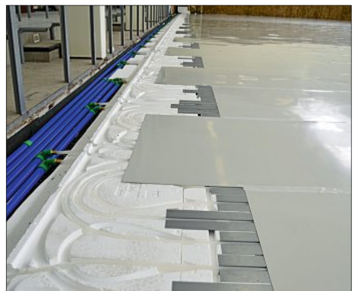
Die Arbeiten in der Norderneyer Sporthalle an der Mühle gehen planmäßig voran. In der vergangenen Woche wurde die Fußbodenheizung verlegt – ganz ohne Probleme, wie Monteur Norbert Maxam von der ausführenden Firma Athe-Therm mitteilt. Er versichert zudem, dass diese Heizungen ewig halten würden, solange sie niemand mutwillig beschädige. Weitergehen wird es heute mit der Dämmung, wie Manfred Hahnen, Vorsitzender des TuS Norderney, bestätigt. In etwa drei Wochen sollen die Arbeiten am Boden abgeschlossen sein. FOTO: SÖRRIES
