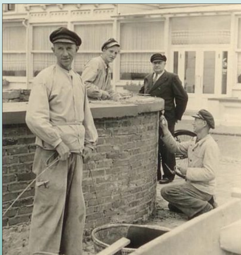
Bau der Veranda des Hauses Friedrichstraße/Ecke Damenpfad im Jahr 1953 mit (von links): Gretus van Ellen, Hans Rass, Firmenchef Wilhelm Becker und Karl Wirdemann.
