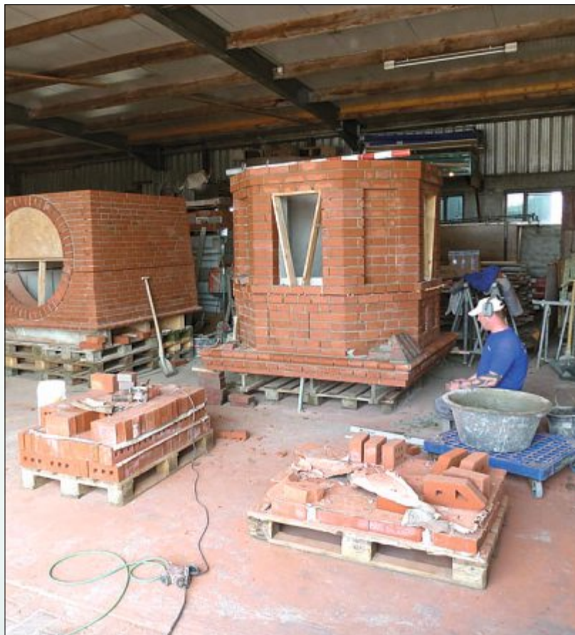
Der Bau der Formteile für den Uhrenturm erfolgten in sorgfältiger Handarbeit.
