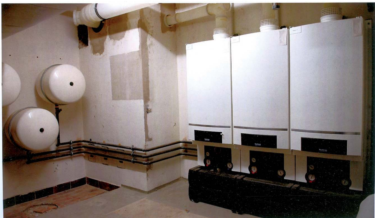
Brennwertkessel-Kaskade-Therapiegebäude
