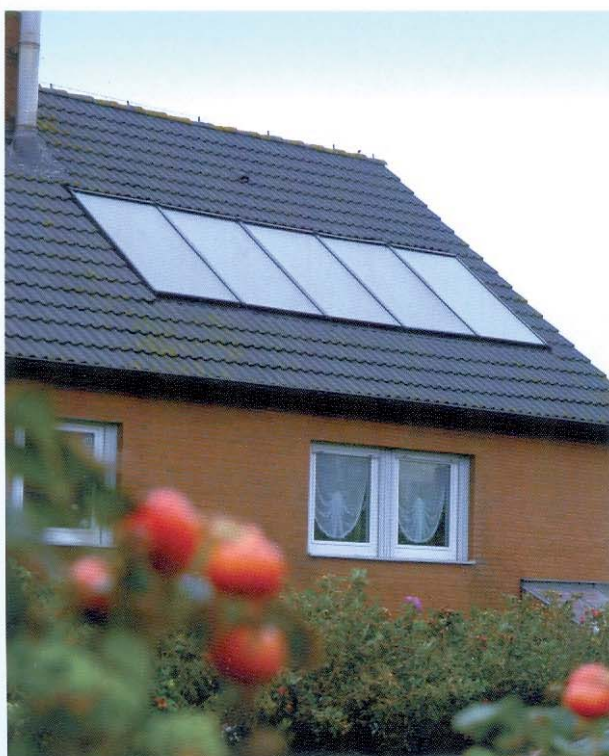
Indach-Flachkollektoren-Solaranlage
