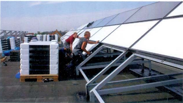
Montage der Solaranlage
