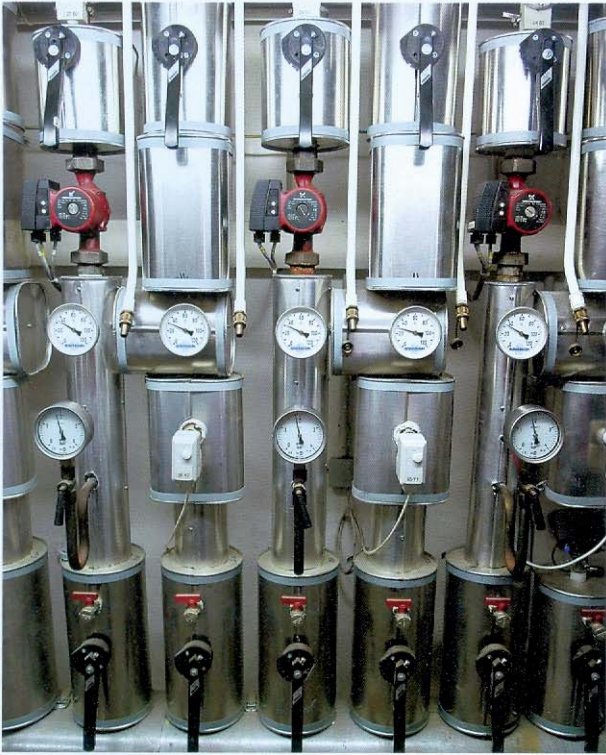
Verteiler Nahwärmeversorgung
