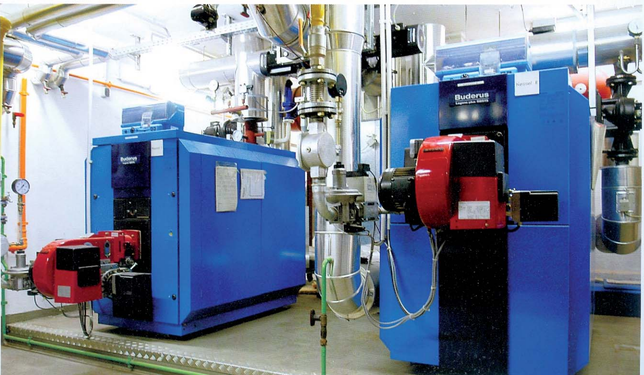
Heizkesselanlage Nahwärmeversorgung
