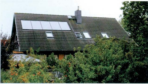
Indach-Solarkollektoren
