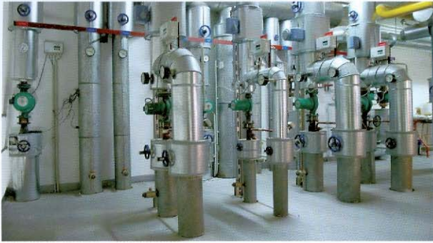
Heizungsverteiler Hauptgebäude
