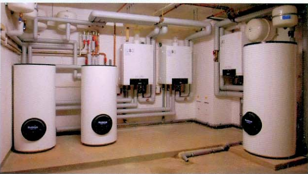
Kleinkesselanlagen mit Brennwerttechnik
