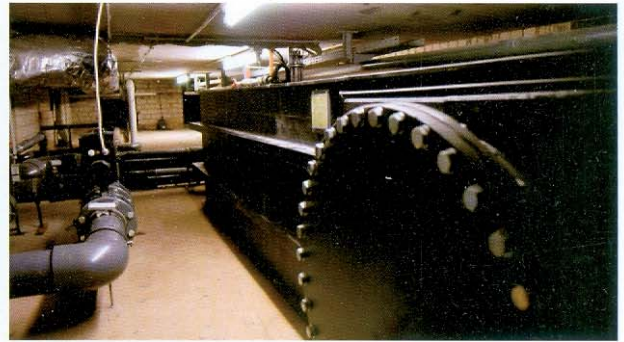
Schwammwasserbehälter für die Schwimmbadanlage
