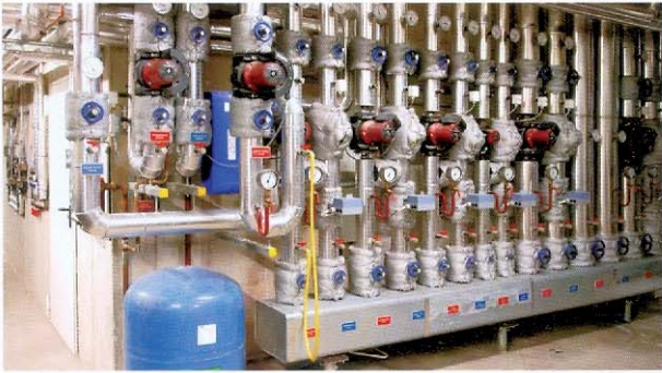
Heizungsverteiler Neubau
