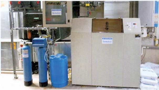
Chlorelektrolyse
