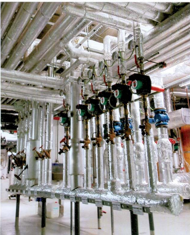
Brauchwasserverteiler
