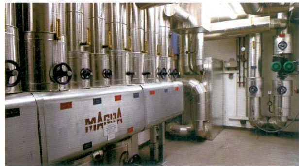
Übergabestation im Kurhaus von der Nahwärmeversorgung
