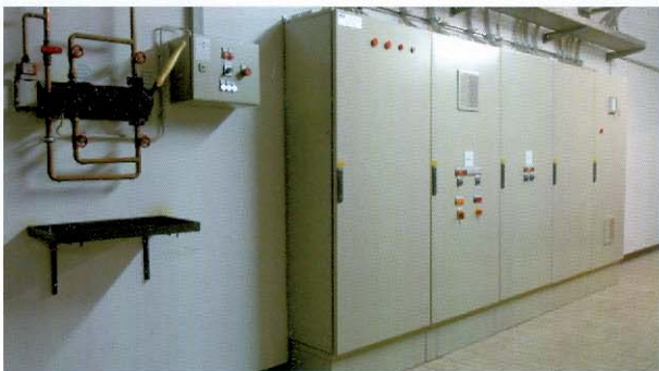
Ölverteiler Notstromanlage
