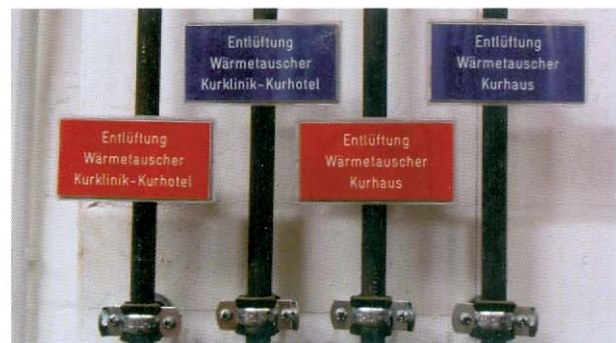
Übergabestation im Kurhaus von der Nahwärmeversorgung
