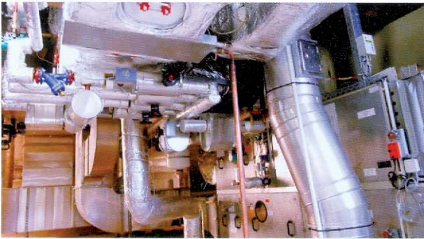
Kühlregister Lüftung
