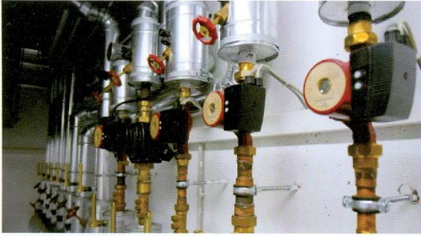
Zirkulationswasserverteiler
