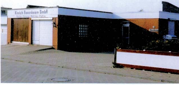
Ehemalige Werkstatt und Lagerräume im Gewerbegebiet 7
