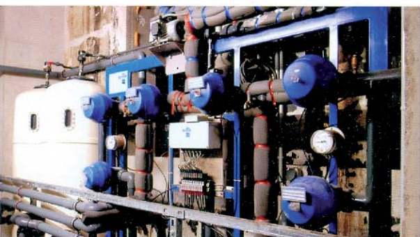
Schwimmbad-Enteisungsanlage
