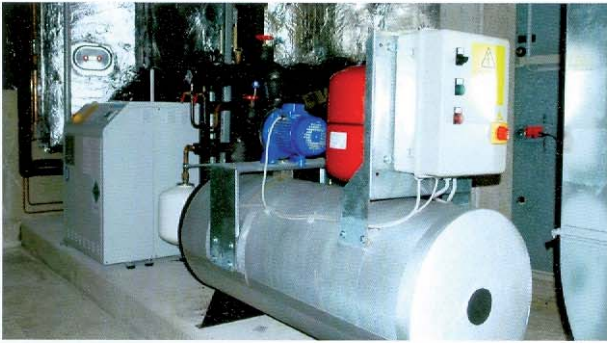
Kaltwassersatz Klimaanlage
