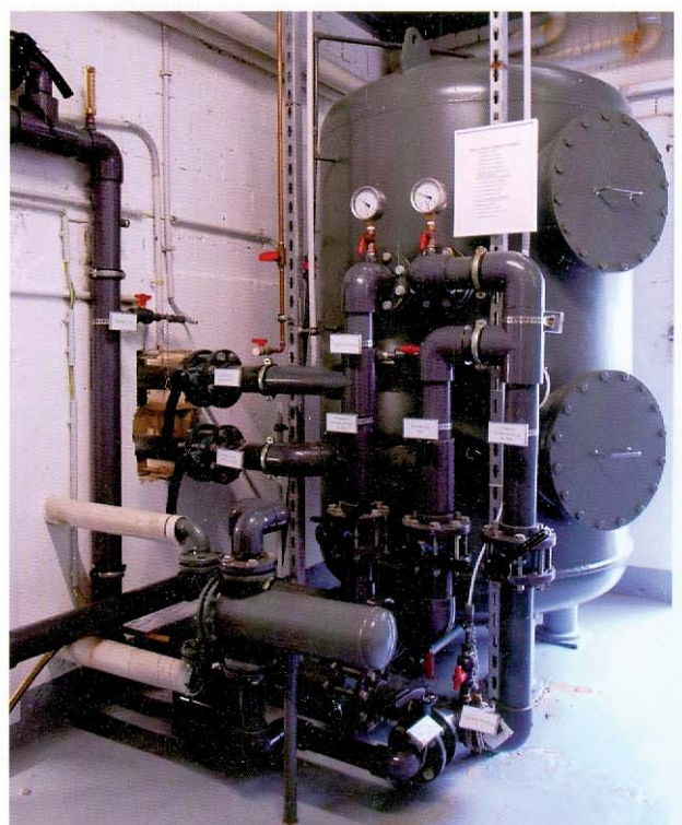
Schwimmbad-Filteranlage
