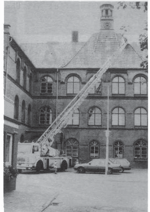
Reparatur der Sturmschäden
