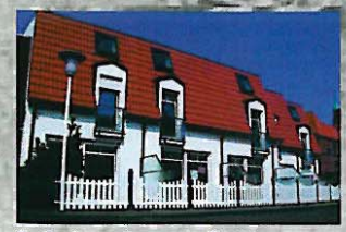
Ferienhaus Langestraße 35 in stadt- u. strandnaher Lage, m. 3 Schlafräumen, 2 Bädern, Wohnzimmer, Küchenecke, Eßplatz u. Südwestterrasse
