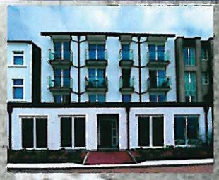
Villa Theresen Kaiserstr. 4 2- und 3-Raum-Appartements, freier Seeblick, hochwertig ausgestattet, neu in 2003
