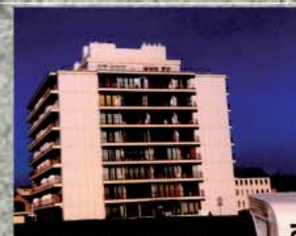
Kaiserhof Kaiserstraße 15 - 16 1- 2-Raum-Wohnungen, gut ausgestattet in stadt- und strandnaher Lage, Seeblick; Schwimmbad, Sauna
