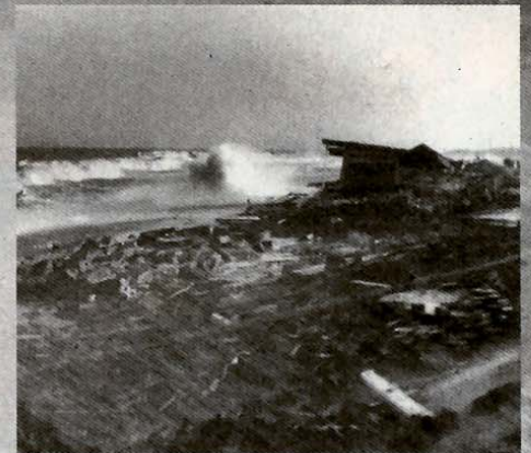
Schwere Zerstörung am Januskopf 1962
