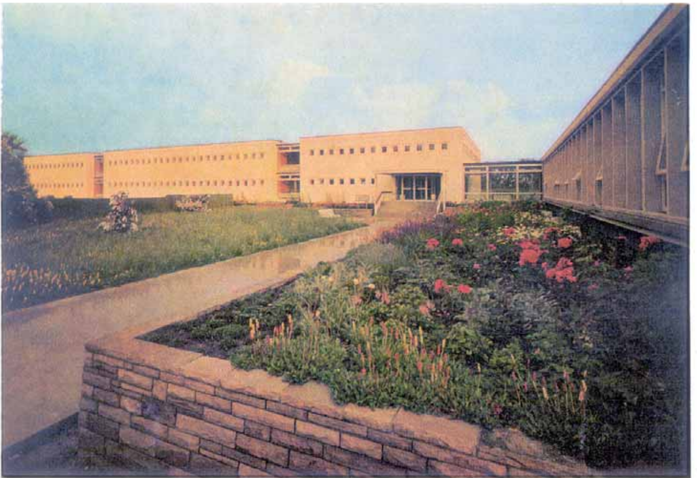
Kurmittelhaus und Hauptverwaltung
