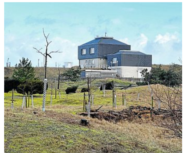
Kaum Baumbewuchs auf der Fläche gegenüber dem Seehospiz.
