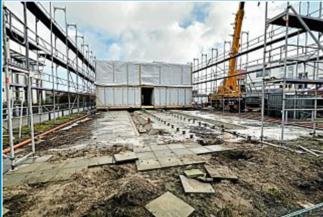
Das Containergebäude der Reha-Klinik werden abgebaut.
