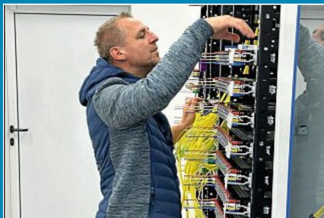
Schritt für Schritt sollen die Internet-Hausanschlüsse stehen.
