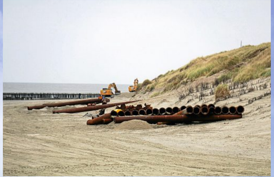
Die Rohre, die zur Sandaufspülung benötigt wurden, sind inzwischen abgeräumt.
