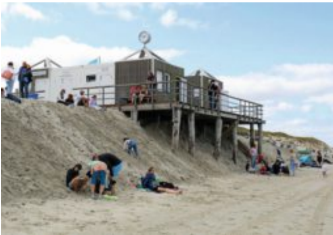
Noch im Sommer konnten die Container platziert werden.
