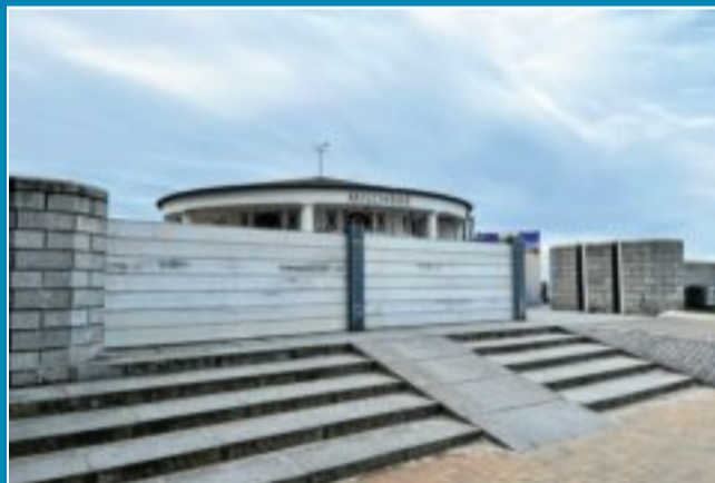
Die Schutzmaßnahmen gegen Sturmfluten wurden umgesetzt.
