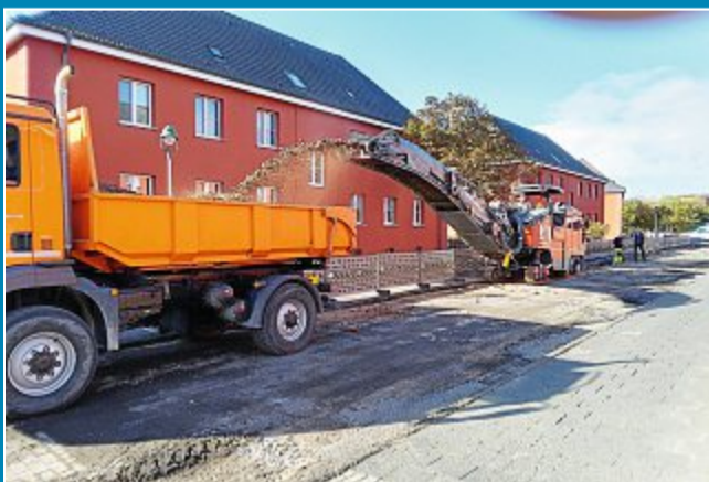
Straßenbelag der Mühlenstraße wurde abgetragen.
