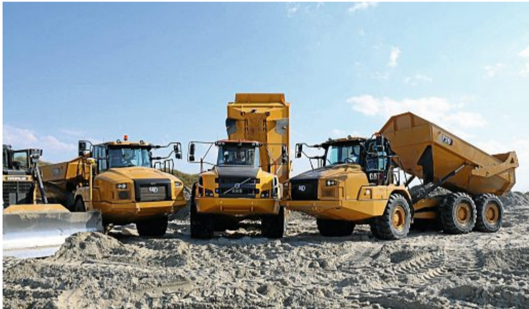
Schwere Arbeit mit schweren Fahrzeugen: die „Dumper“ in den Dünen.
