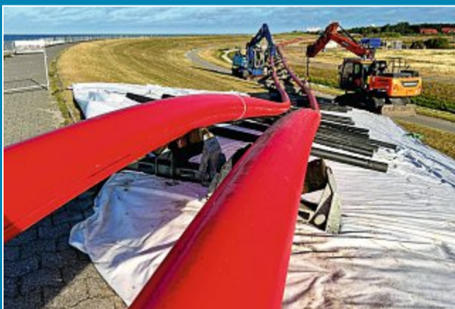
Rohre werden zur Oase verbracht.
