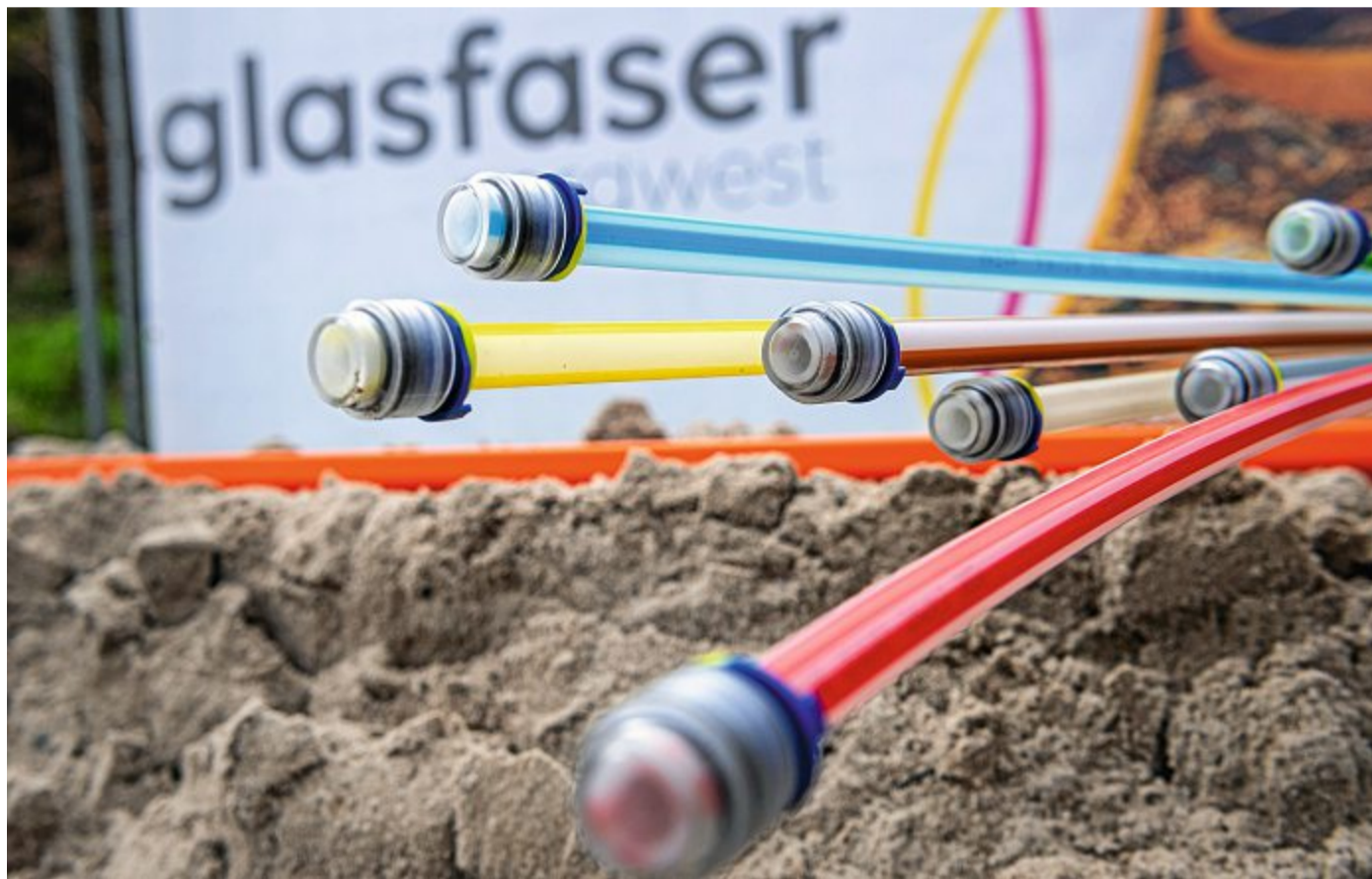
Auf den Baustellen geschieht zurzeit nichts. Die ersten Anschlüsse sollen im Oostland realisiert werden.
