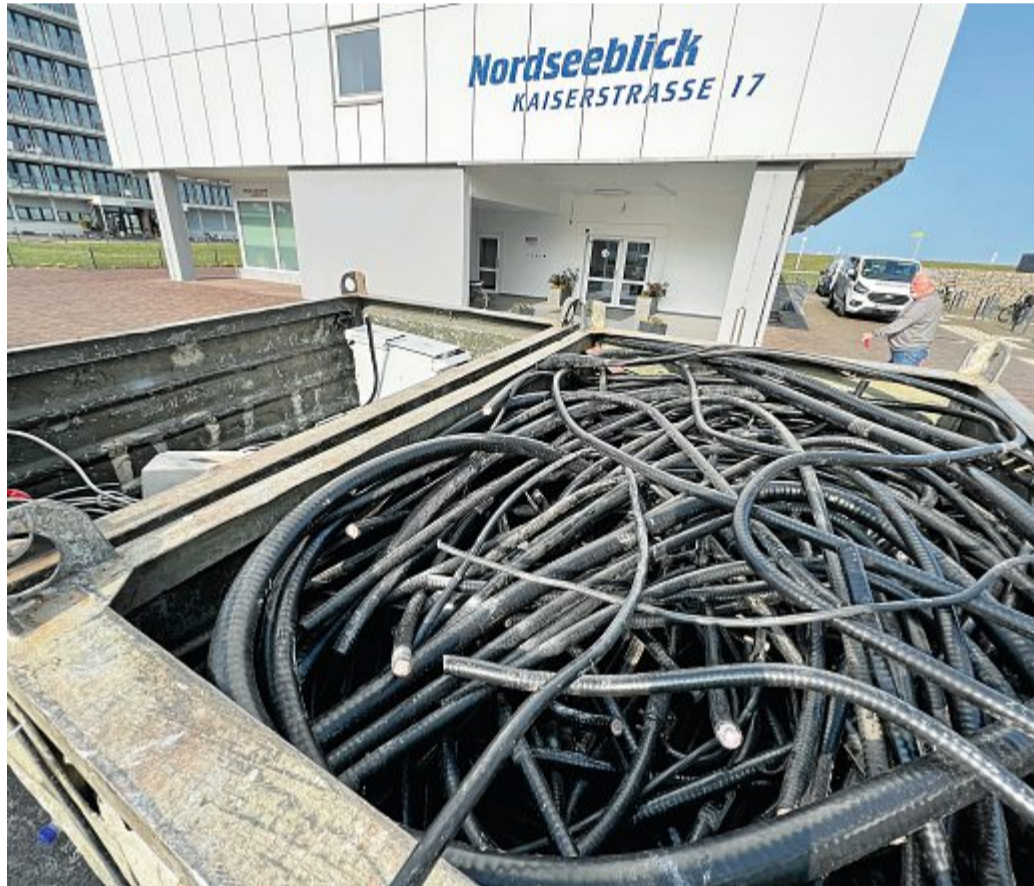
Containerweise Kabel und Anlagenteile vor Haus Seeblick in der Kaiserstraße 17.
