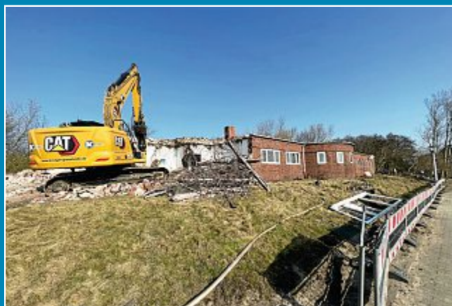
Das „Gruko-Gebäude“ wird abgerissen.
