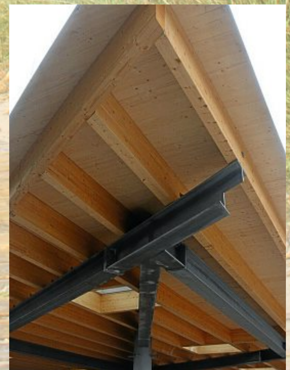
Das neue Dach: Schutz auch für Räder.
