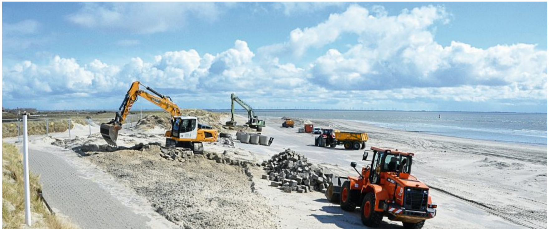
Die Arbeiten am ersten Bauabschnitt begannen bereits im April.
