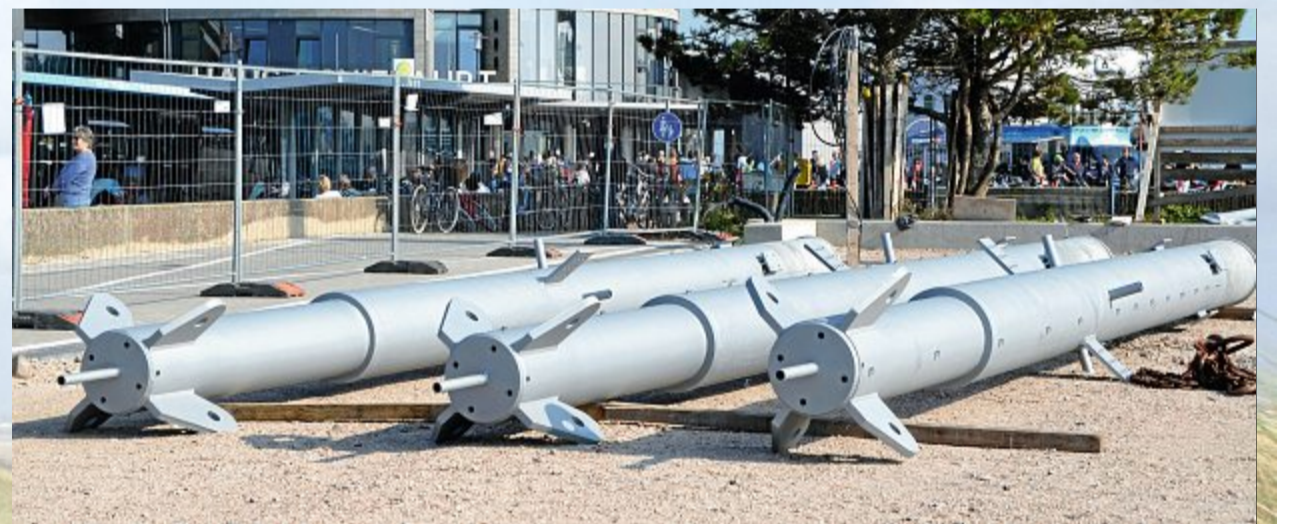
Der Bau der Fahrradabstellanlage wurde wieder aufgenommen. Hier: die Stahlträger.
