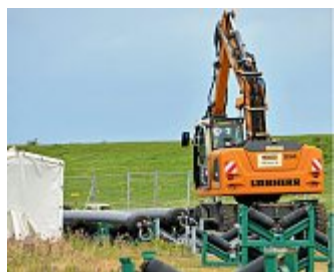
Auf Norderney werden Leerrohre für Hilgenriedersiel zusammengesweißt.
