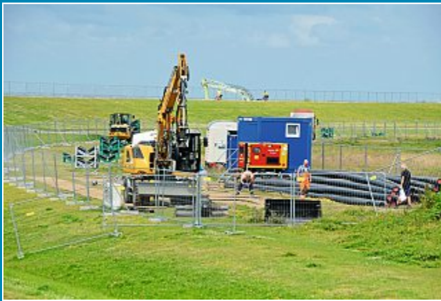
Das Schweißen der TenneT-Rohre beginnt.
