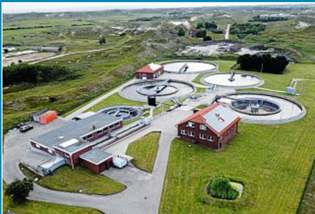
Die Norderneyer Kläranlage wird 50.
