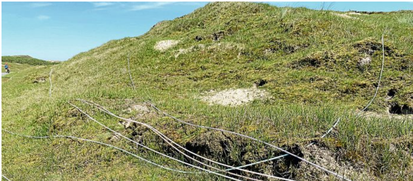
Die sogenannten Mikroröhre sind inzwischen verlegt. Im Herbst werden dann die Glasfaserkabel eingeblasen.
