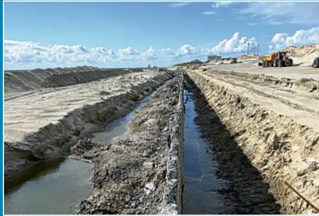
Tief und schnell gegraben wird bei den Bauarbeiten zum Küstenschutz am Westdeich der Insel.
