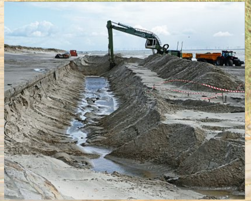
Ein tiefer Graben tut sich jetzt vor dem Deckwerk auf.
