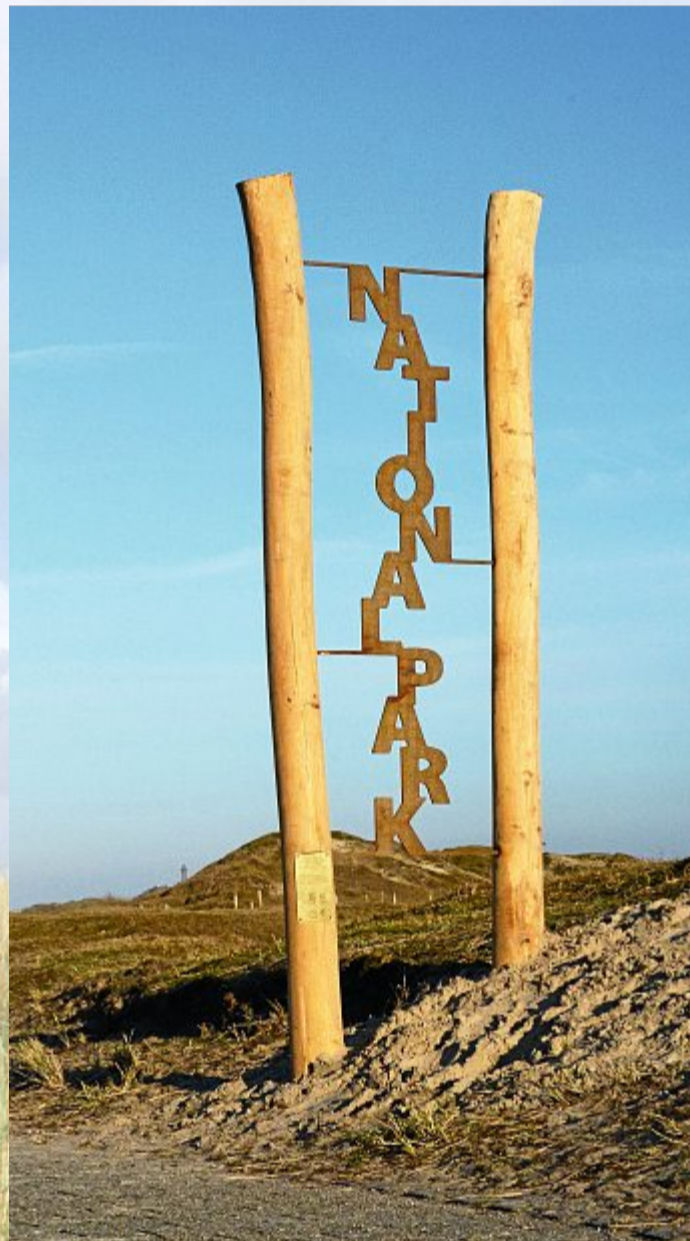
Das „Tor zum Nationalpark“ ist mittlerweile schon zerstört.
