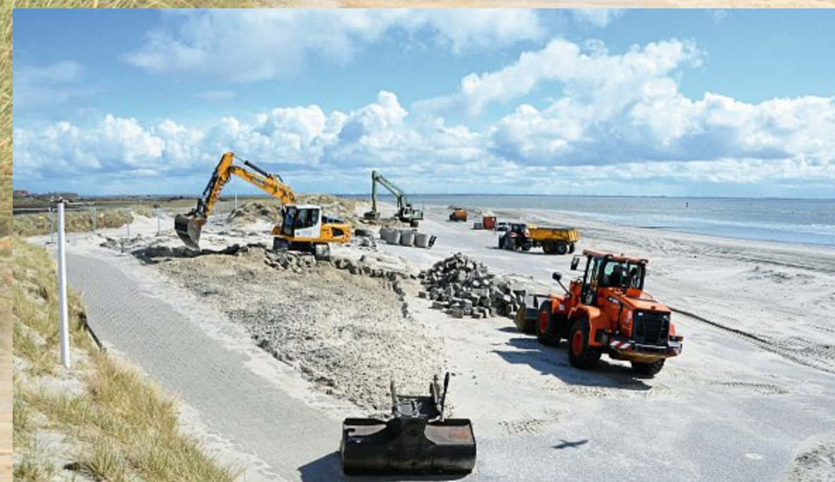
Die Bauarbeiten am Westdeich haben Montag begonnen.
