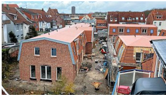
Blick aus westlicher Richtung.
