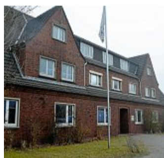
Das alte Gebäude der FSK.
