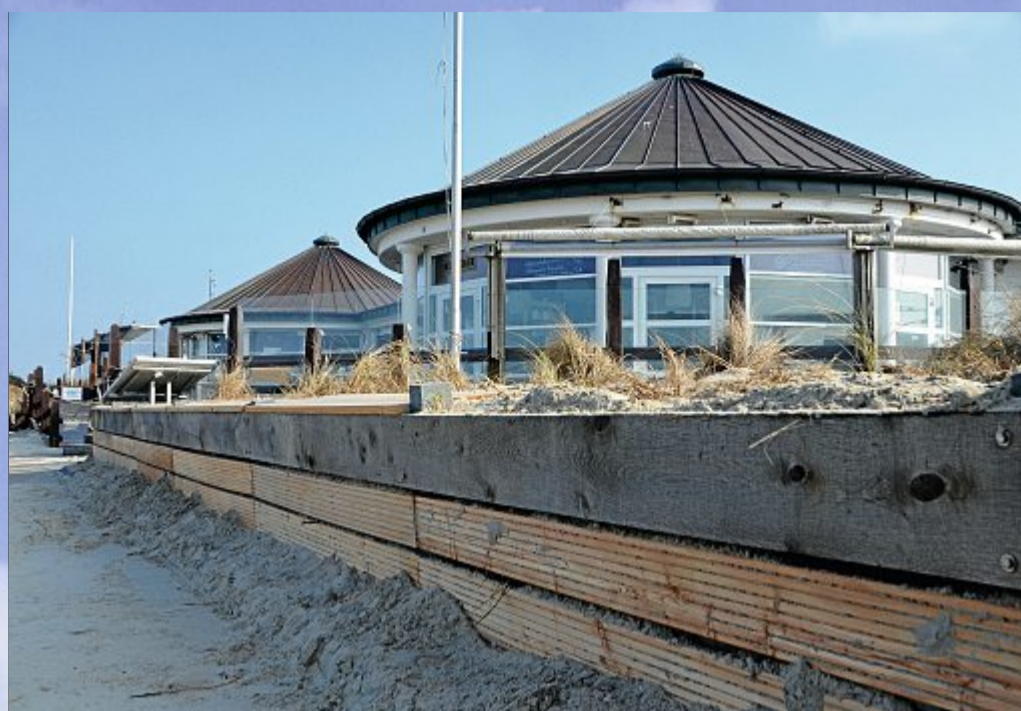
Rings um Surfcafé und Riffkieker gibt es ebenfalls Renovierungsarbeiten.
