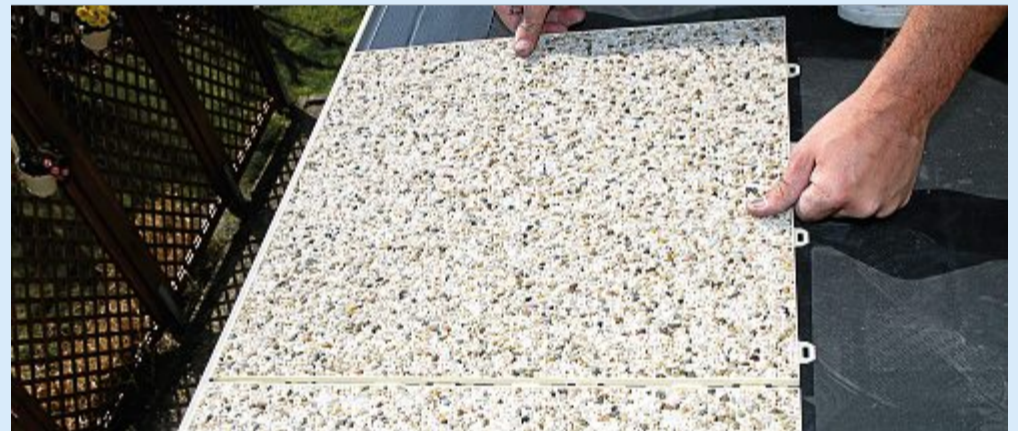
Einfache und schnelle Sanierung mit Fertigelementen.
