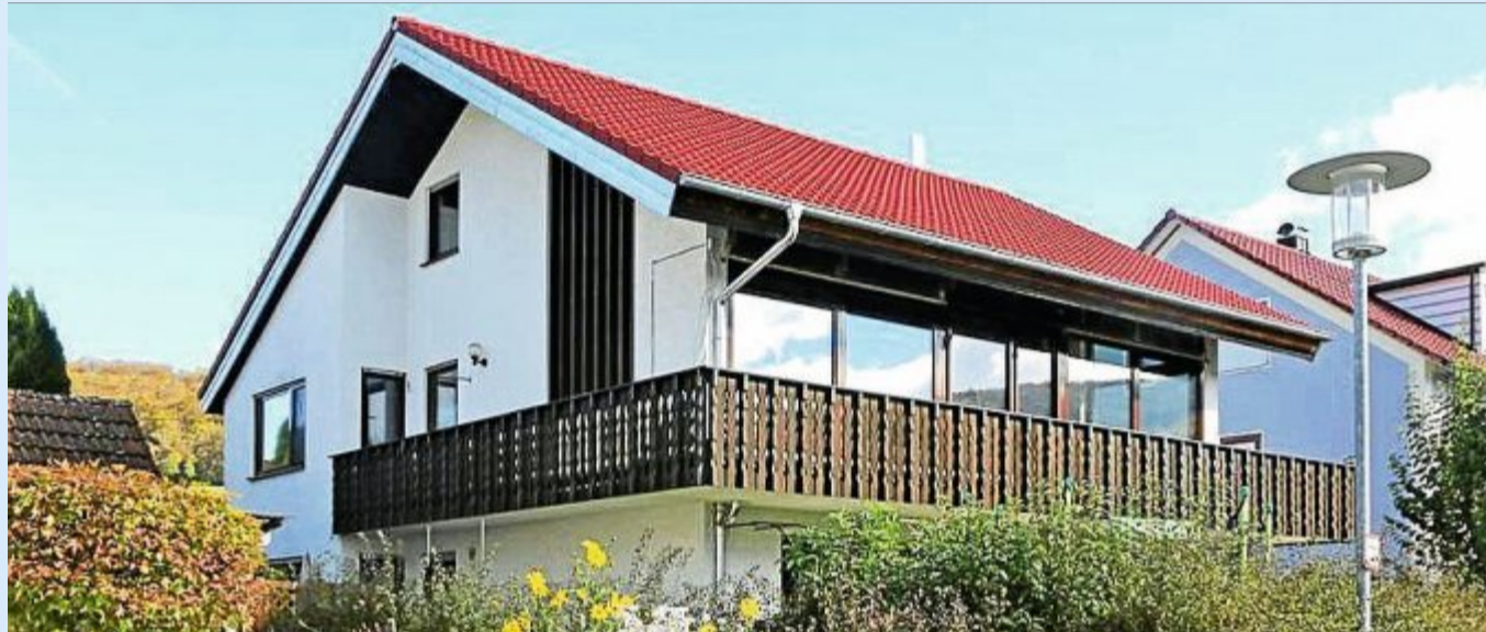
Mit einer konsequenten Rundumdämmung lassen sich ältere Häuser auf eine zukunftssichere Energieeffizienzklasse hin modernisieren. FOTOS: DJD
