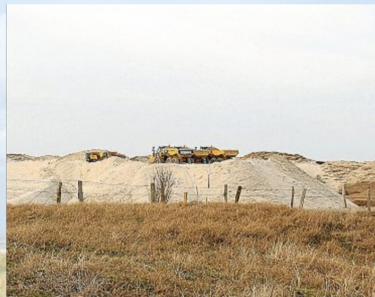
Weiterhin ist schweres Gerät im Einsatz.
