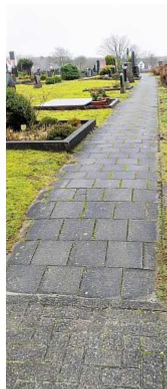
Hier wird neu gepflastert.
