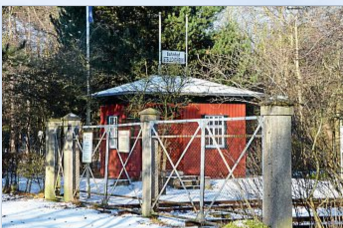
Im Winter ist der Blick frei auf den Bahnhof Steldichein.
