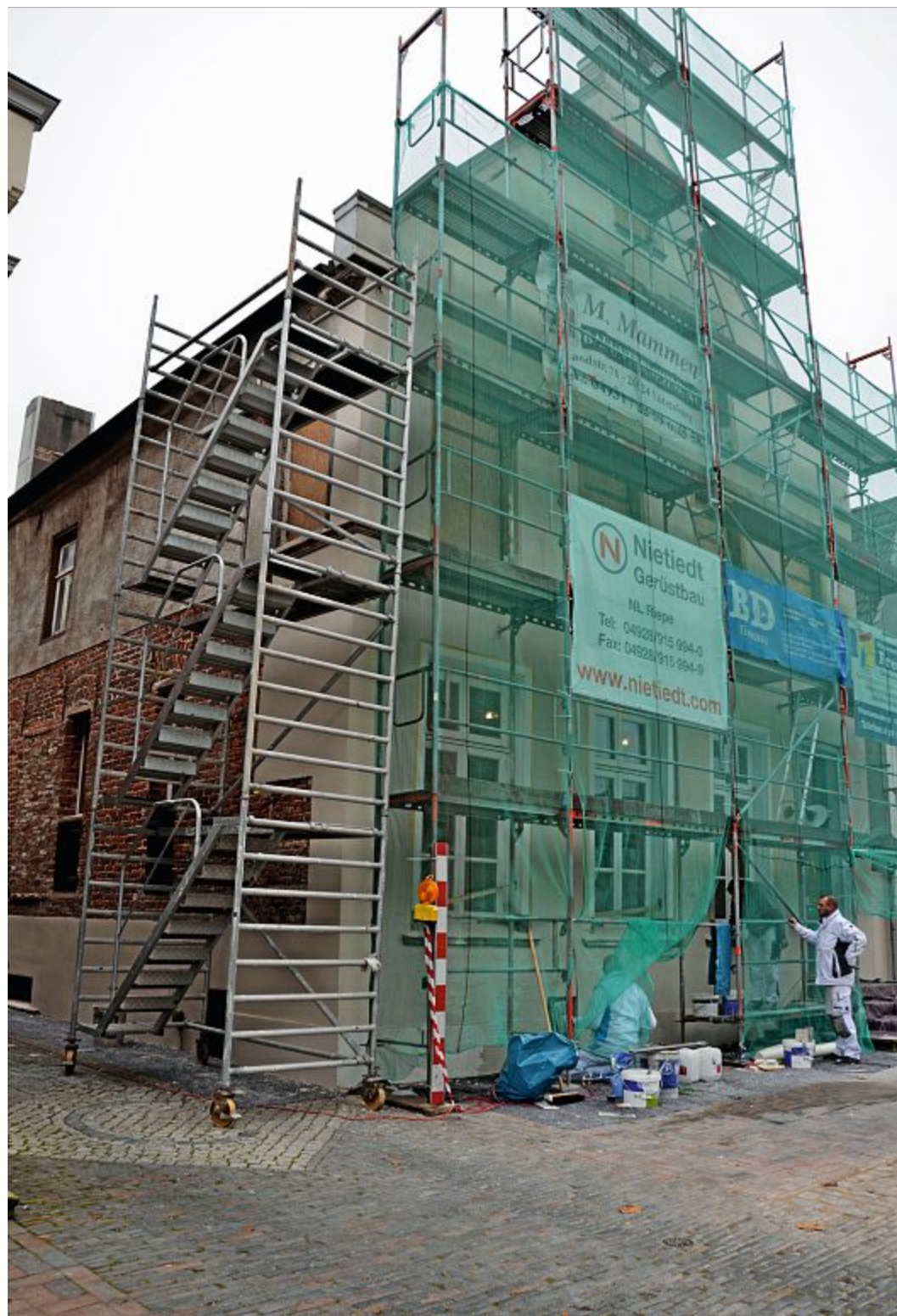
Wird umfassend saniert: Die Fassade und die Fenster des Hunderte Jahre alten Gebäudes Am Markt 33, das seit 2003 die Sammlung Oswald-von Diepholz beheimatet und als zweites Norder Teemuseum die höfische Teekultur in den Fokus der Besucher rückt. FOTO: AHRENDIS
