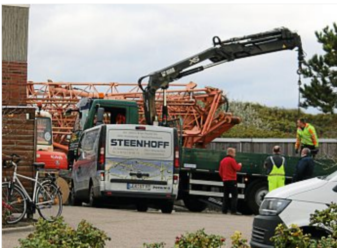
Als erstes musste ein Kran aufgestellt werden.
