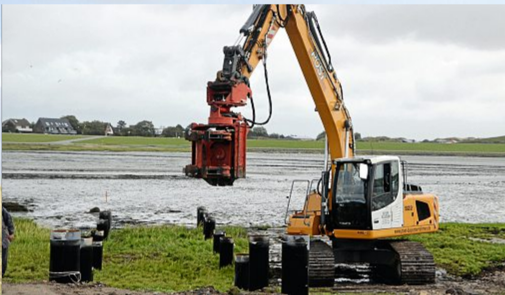
Der Bau des „Stegs ins Watt“ hat begonnen.
