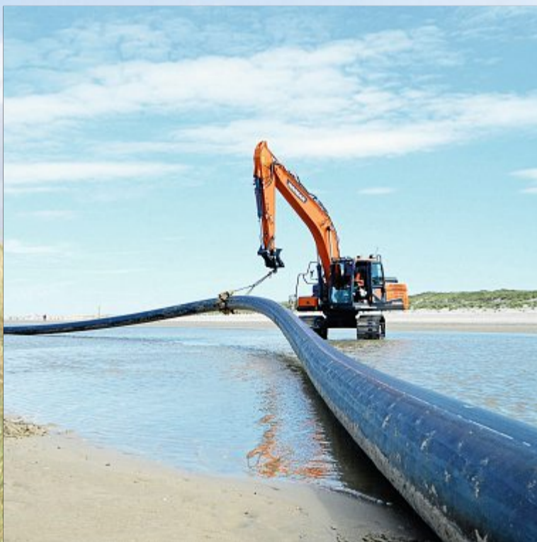
Mit viel PS werden die Leerrohre bewegt.
