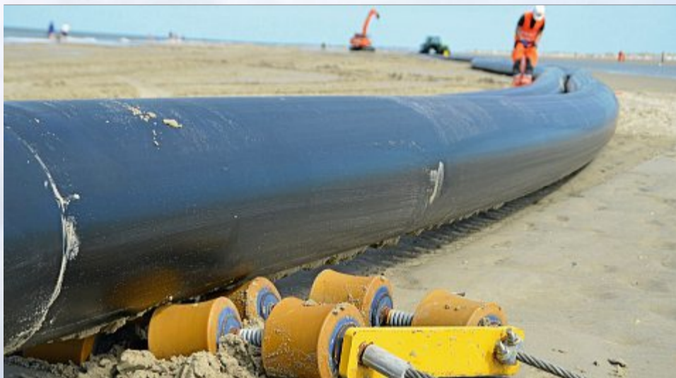
Kettenrollen sorgen dafür, dass es besser läuft.
