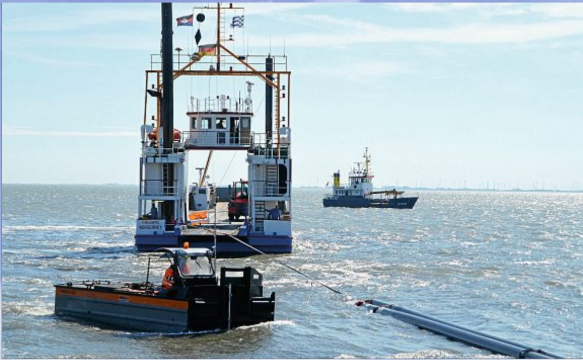
Donnerstag wurden die ersten knapp 1.400 Meter Kabelleerrohre der TenneT ins Wasser gezogen.
