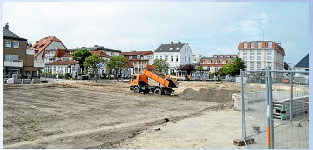
Die letzten Fuder Sand zum Verfüllen werden angeliefert
