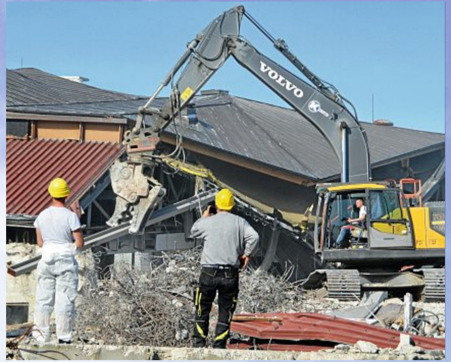
Abbrucharbeiten am 7. April.
