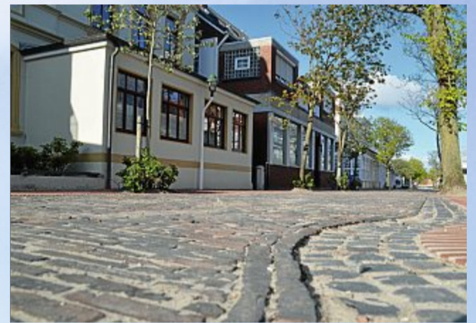
Vor drei Wochen fertiggestellt: die Benekestraße.
