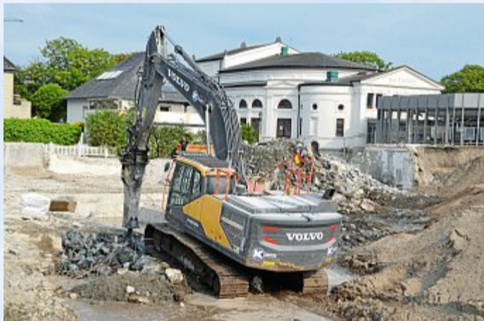
In Kürze enden die Arbeiten auf dem Gelände „Haus der Insel“.
