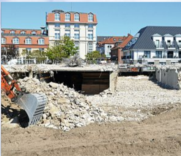
Im Keller angekommen: Abrissarbeiten beim HdI.
