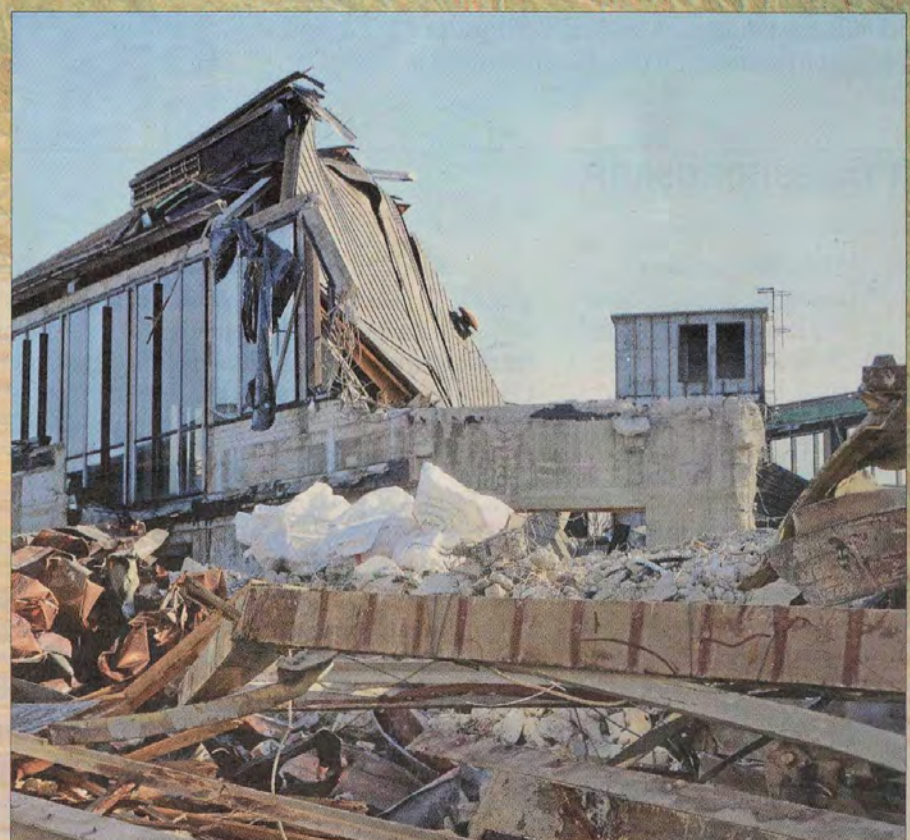
Haus der Insel: Mit den Abrissarbeiten geht es sichtlich voran.
