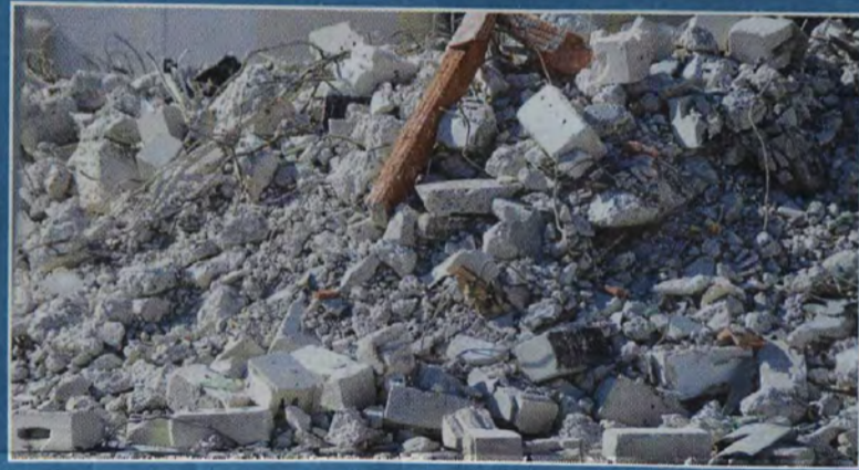
BAUWESEN: Abriss soll am Montag weitergehen.
