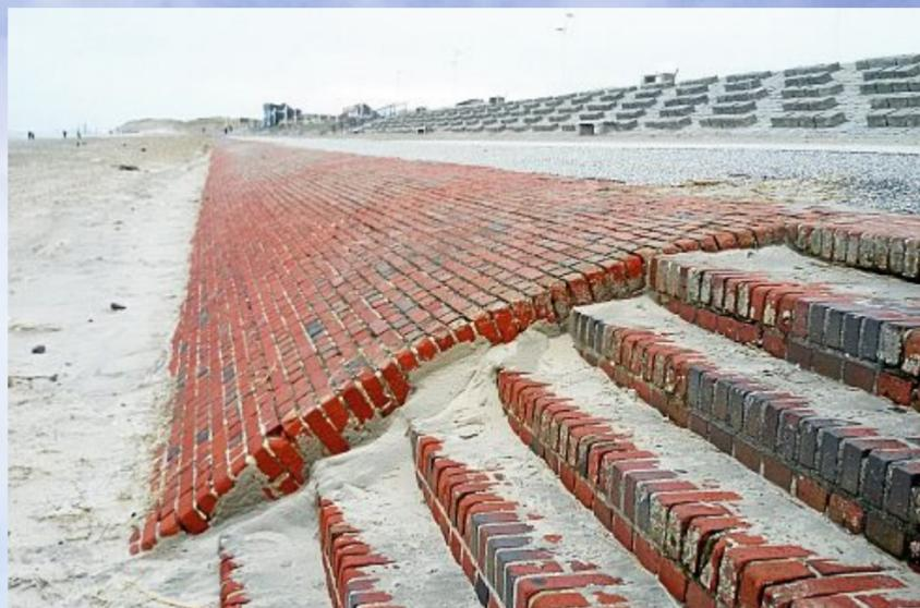
Wieder aufgetaucht: Das mit Klinker gebaute Deckwerk.
