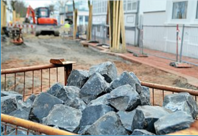
BAU Benekestraße bald fertig.
