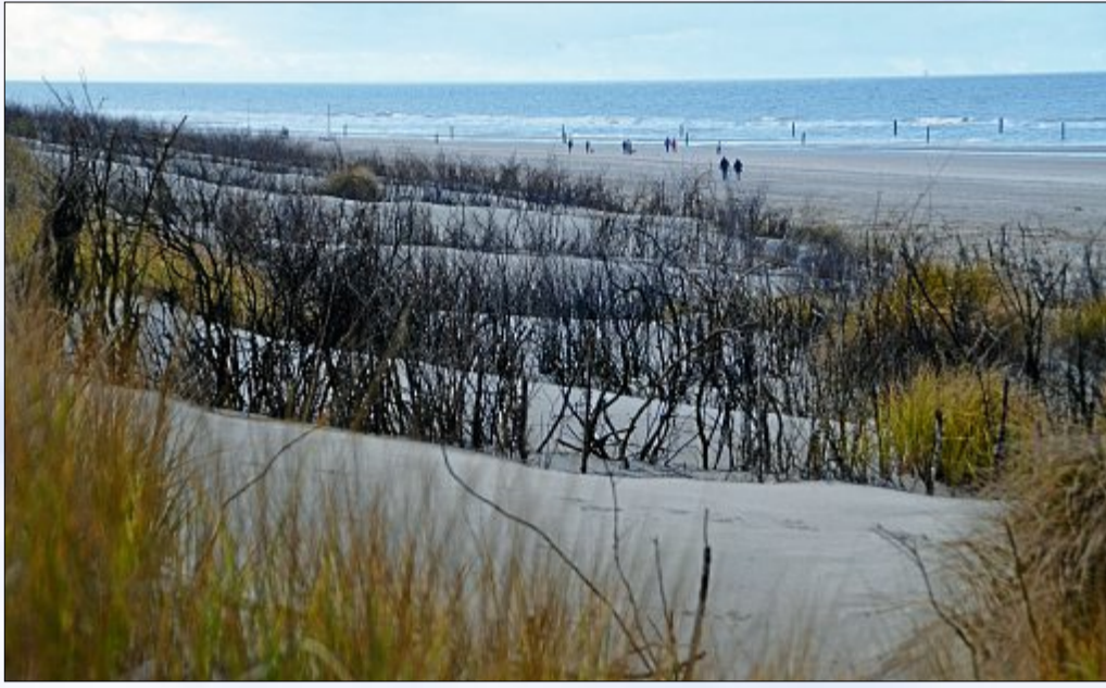
Noch leere Buschbecken warten auf die Pflanzarbeiten.
