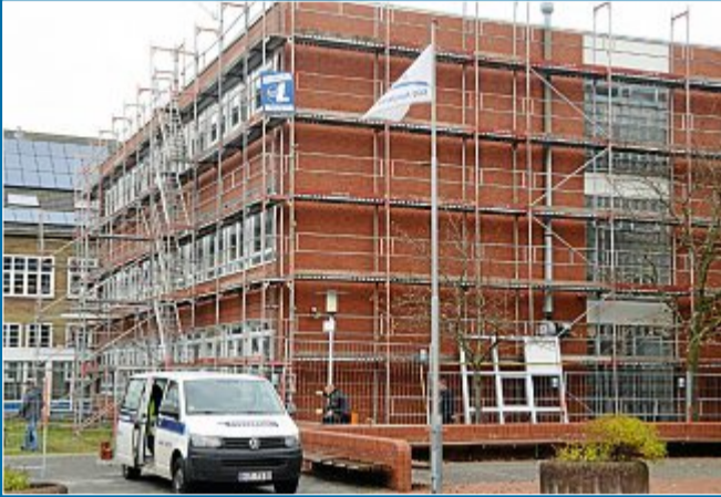
POLITIK BAUARBEITEN AN DER KOOPERATIVEN GESAMTSCHULE IN VOLLEM GANGE
