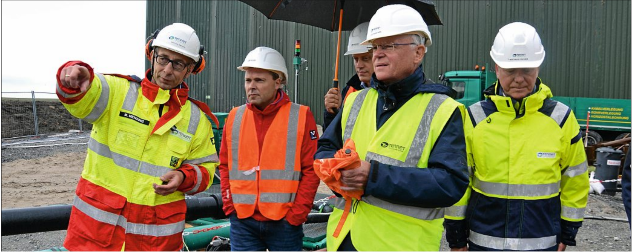
An der Baustelle von TenneT erklärte Projektleiter Matthias Mensing (links) dem Ministerpräsidenten Stephan Weil (2. v. r.), wie eine Horizontalbohrung unter der Insel funktioniert. FOTOS (2): JANSSEN
