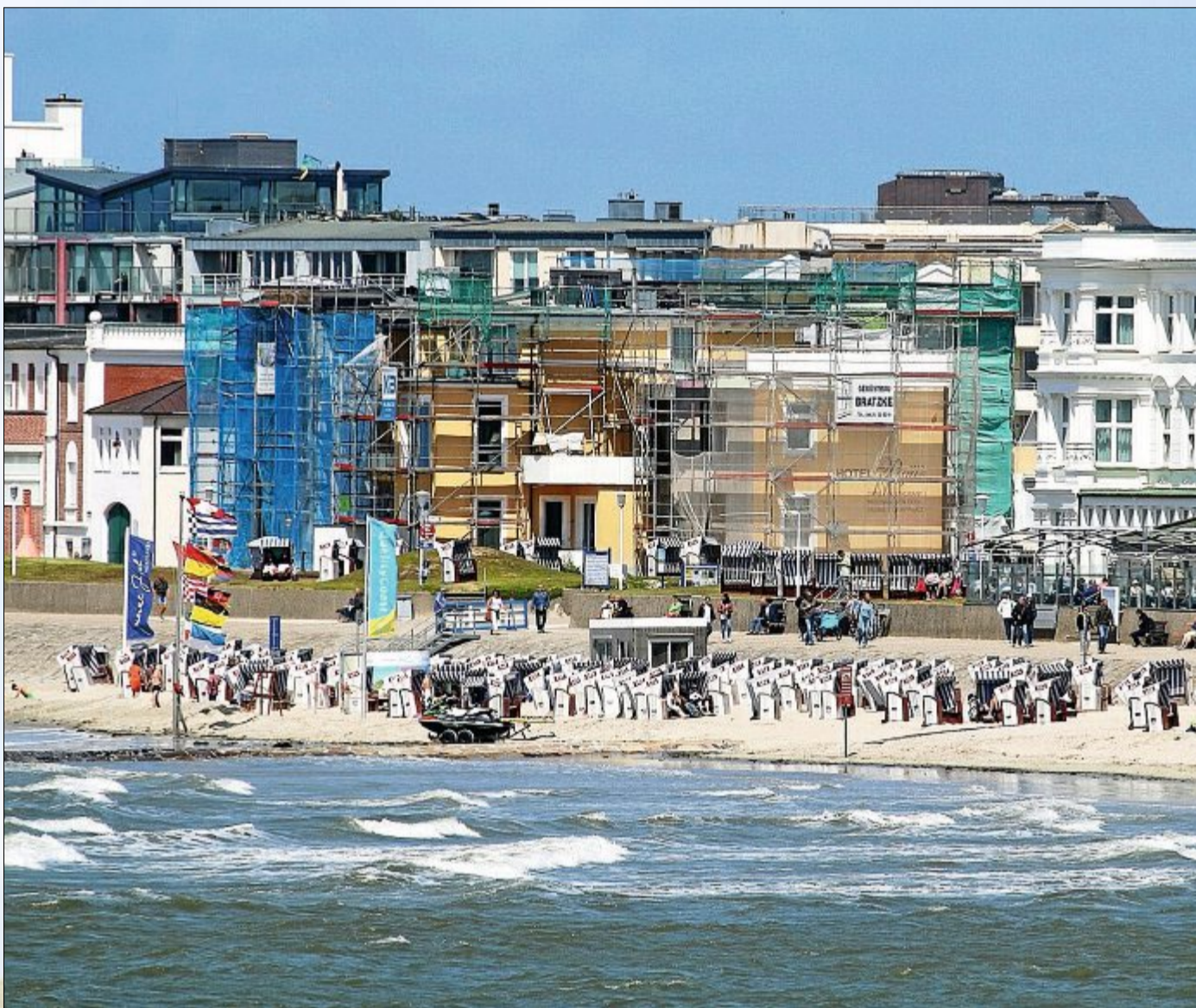
Nicht gerade ein schöner Anblick bei der Ankunft auf Norderney: Fassadenarbeiten der Häuser in Strandlage.
