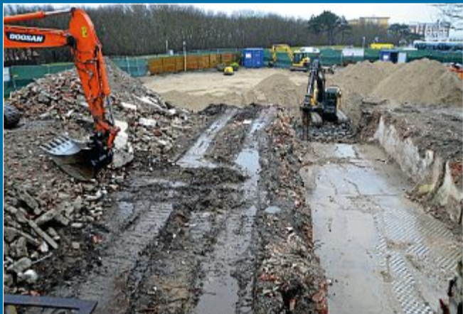
KURMITTELHAUS Nach der Innen-Demontage fallen jetzt Mauern
