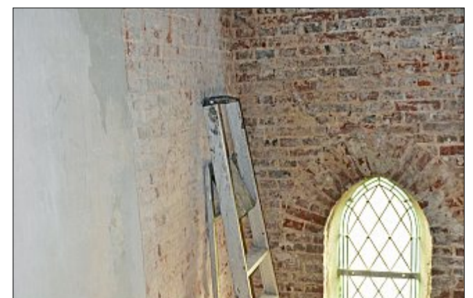
Im Inneren des Turms soll an manchen Stellen der Putz nun ganz wegbleiben, damit eine bessere Zirkulation herrscht.
