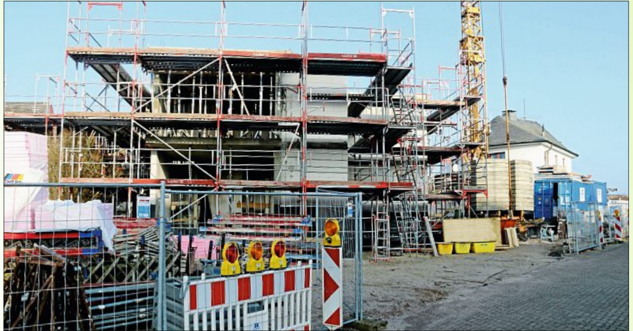
In manch einer Bausaison sprießen neue Gebäude wie Frühlingsblumen aus dem Boden. Wo im Herbst nur eine leere Fläche war, findet sich dann im Frühjahr ein meist fast fertiges Haus. Bis es so weit ist, muss aber fleißig gearbeitet werden. FOTOS (2): NOUN
