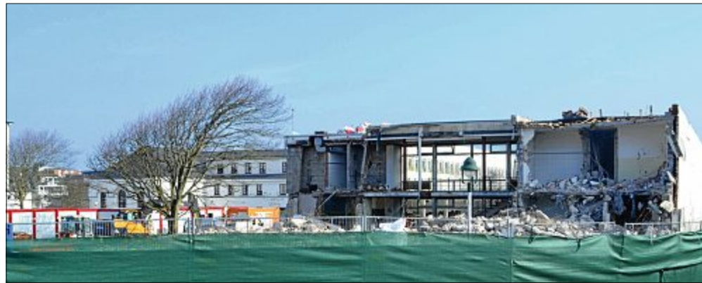
Die sichtbaren Abrissarbeiten am Kurmittelhaus haben nun begonnen.
