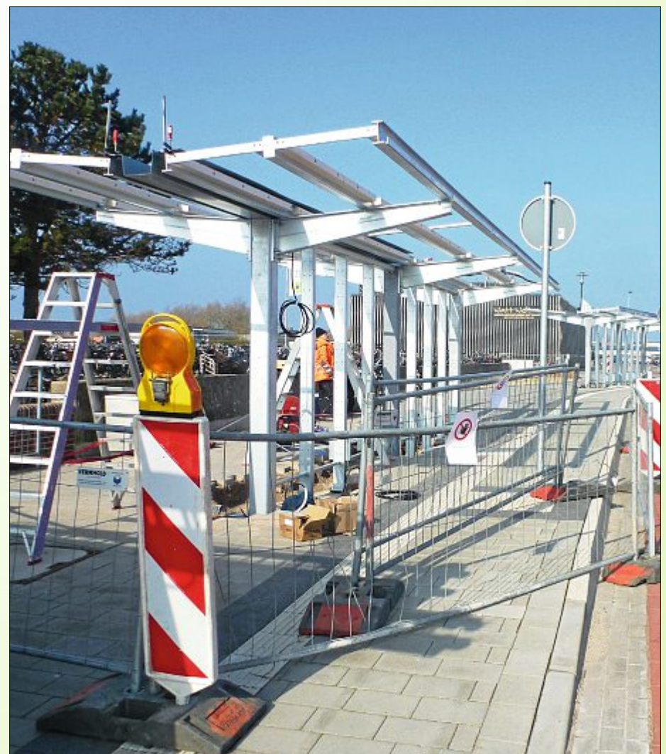
Die Arbeiten am Hafen nehmen immer mehr Form an. Derzeit werden die Bushäuschen aufgestellt, damit man zukünftig im Trockenen warten kann. FOTO: FASTENAU
