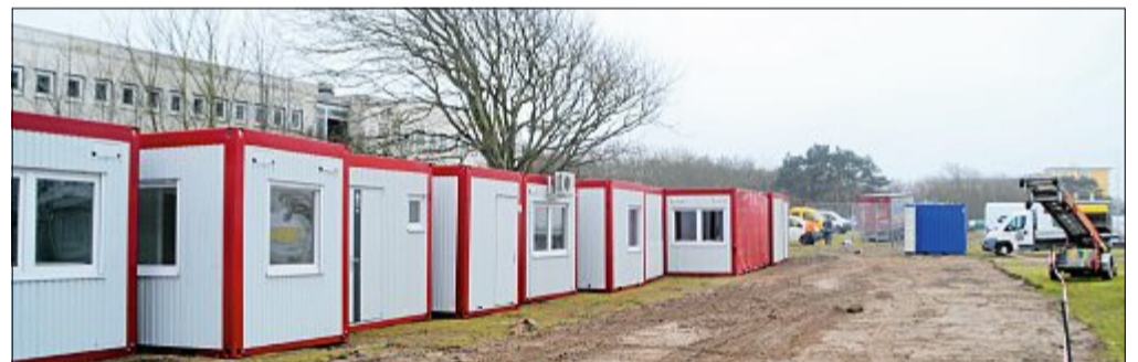
Ein kleines Containerdorf ist bereits entstanden und die Vorarbeiten für den Abriss haben begonnen.
