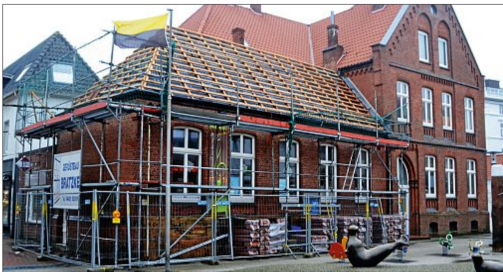
Nur noch der kleine Anbau des Pfarrhauses muss mit Dachziegeln versehen werden. Der Rest ist bereits fertig.
