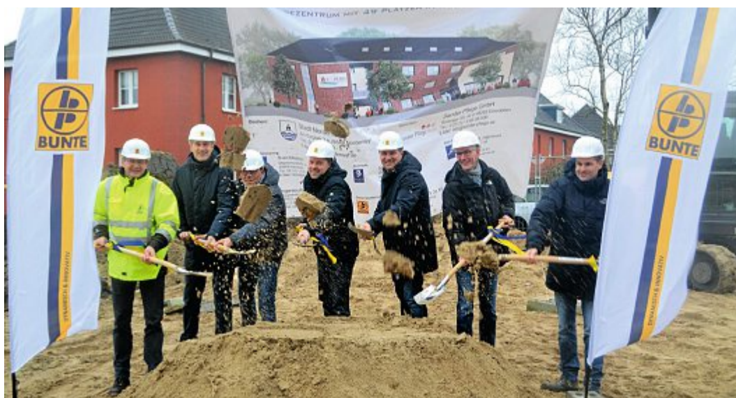
Hoffentlich ist die Sieben eine Glückszahl für den Bau des neuen Gebäudes des Seniorenzentrums „To Huus“, denn ebenso viele Vertreter von Stadt, Architekturbüro, Baufirma und Seniorenzen-
