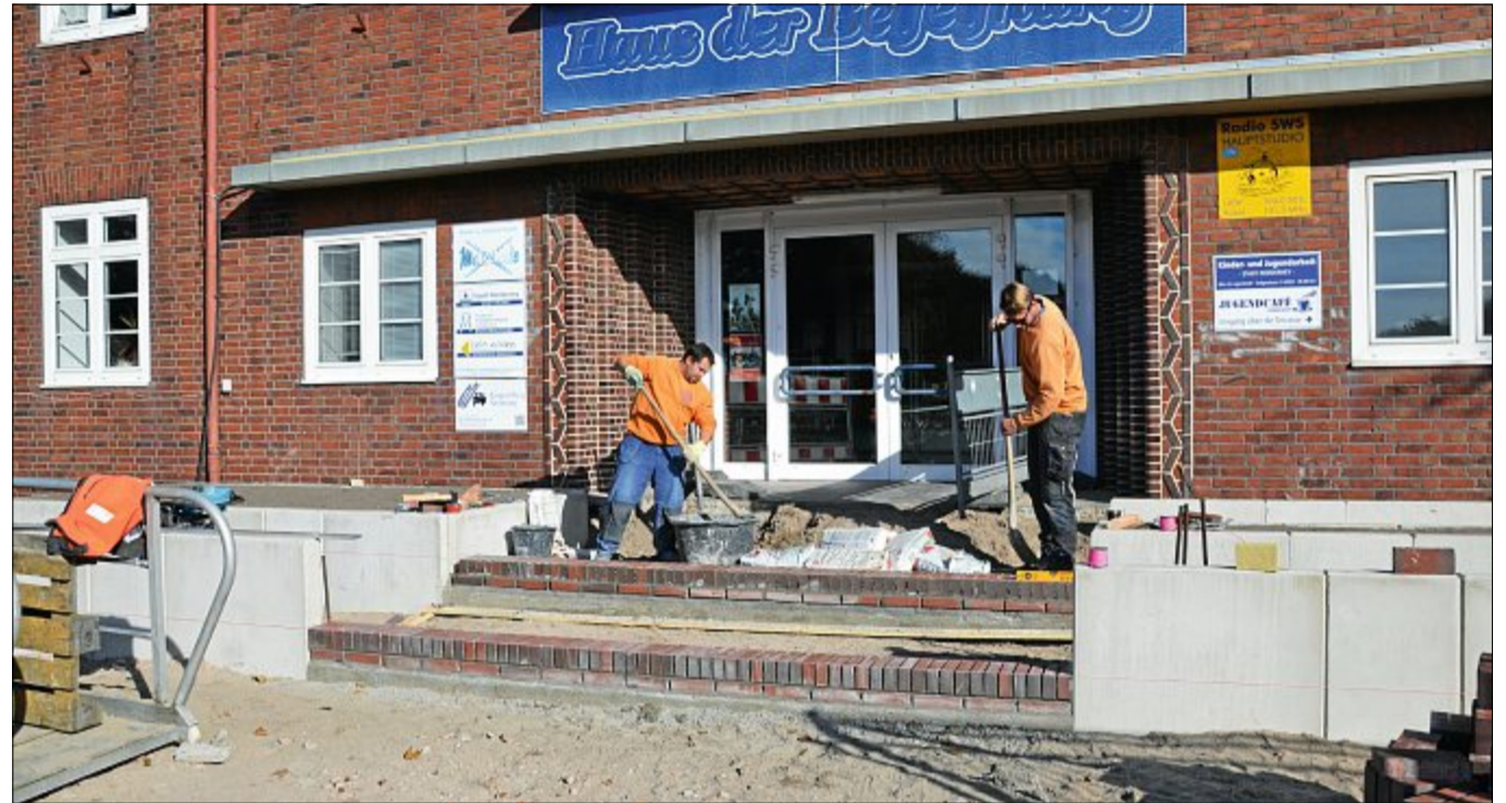
Am Haus der Begegnung wird fleißig gearbeitet. Die Treppenstufen sind bereits zu sehen, die Rampe ist zu errichten.
