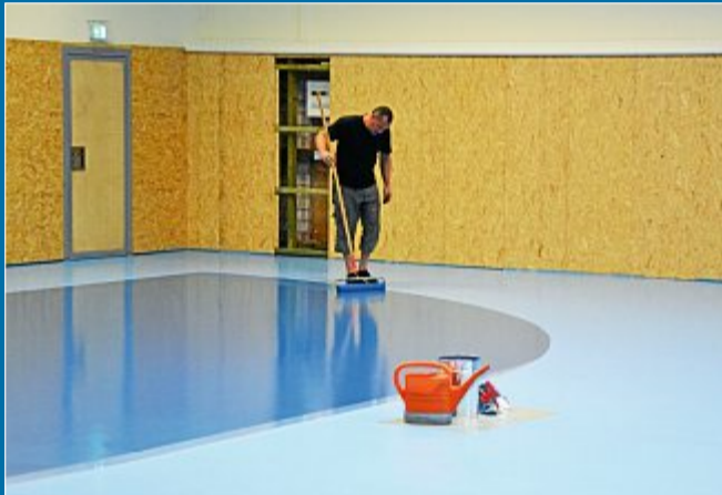
UMBAU Es fehlt nicht mehr viel, bis Sportanlage komplett fertig ist
