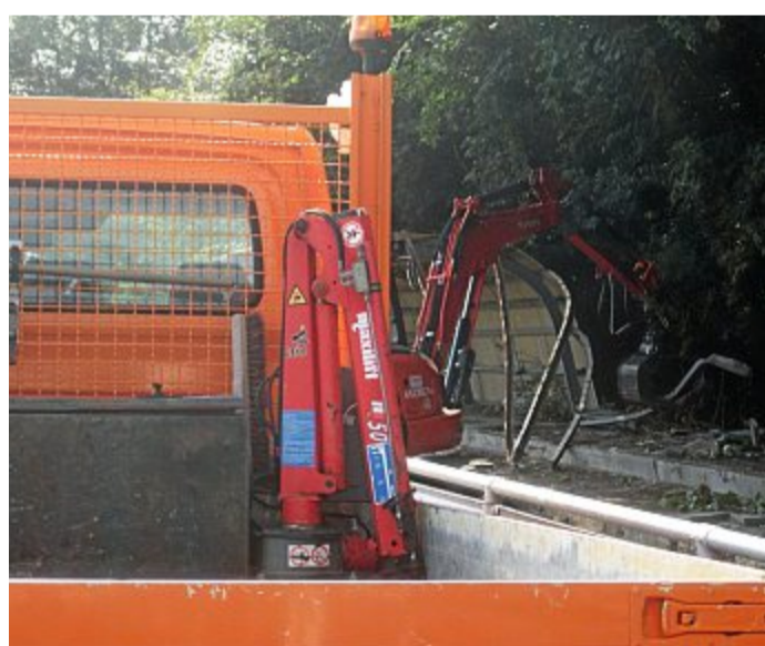
Die Zuschauertribüne am Sportplatz an der Mühle ist in der vergangenen Woche von einem Bagger abgerissen und dann zerlegt worden. Im Rahmen der Baumaßnahmen im gesamten Bereich des Gebiets an der Mühle wird dort eine neue, etwas
