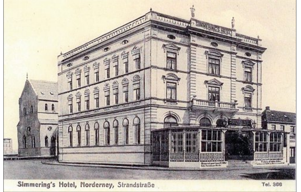
Peter Simmering baute 1891 „Simmerings Hotel“. 1911 steht als Besitzer Friedrich Bartels im Adressbuch, der Oberkellner bei Simmering war. Zu der Zeit ist Simmering nicht mehr in der Einwohnerliste eingetragen. 1935 sind als Besitzerin Emma Bartels, Witwe von Friedrich, und als Geschäftsführer dessen Bruder Walter Bartels eingetragen. 1954 wird das Hotel unter dem Namen „Hansa Hotel“ betrieben. Später wird es zum „Künstlerhaus“. So heißt es noch heute, Inhaber ist Stefan Schnieder. ARCHIV PAHL
